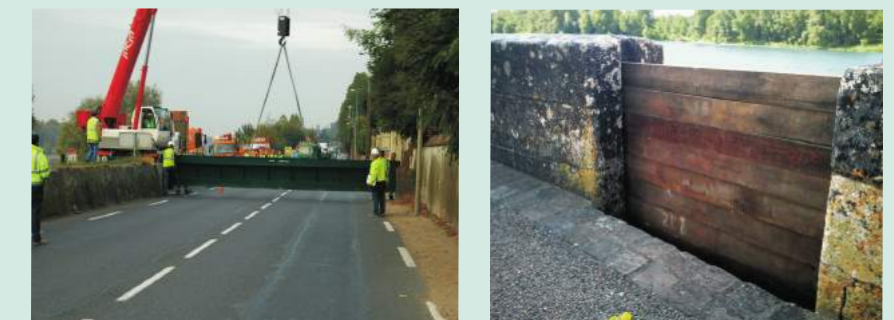
Essais réguliers de mise en place des bouchures.
