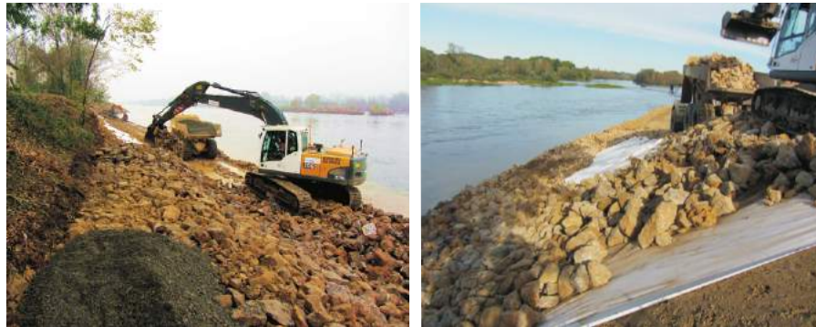
Exemple de renforcement des levées par enrochement
